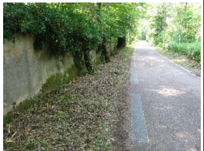
Entretien de la voirie d'accès à l'étang coupe de formation
