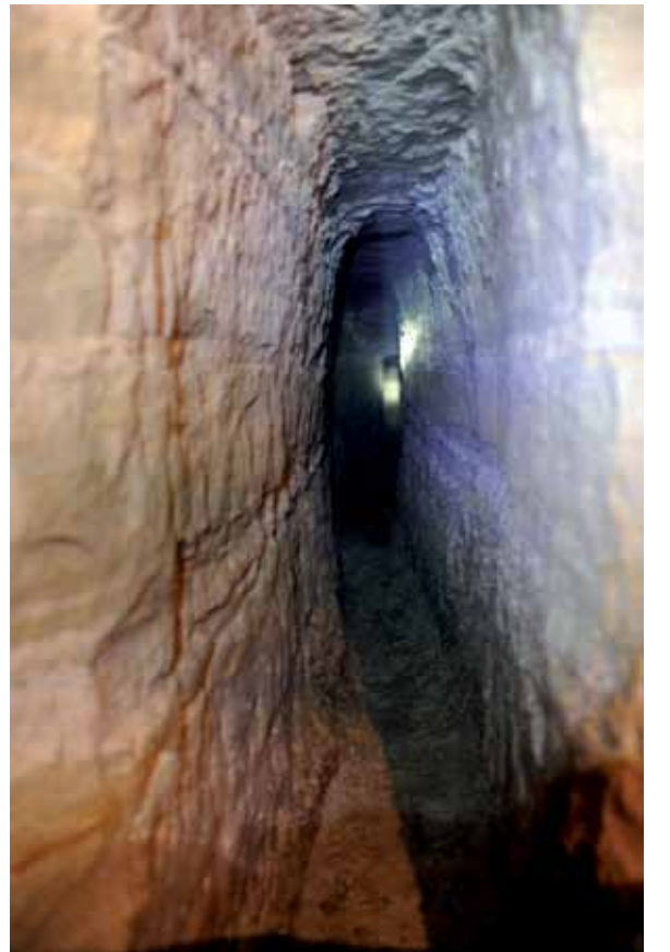
■ Deux exemples de galeries souterraines sous la Croix-Rousse : l'une aux parois renforcées à des fins de sécurité, la seconde taillée à même le substrat. © Jacques Léone - Grand Lyon
